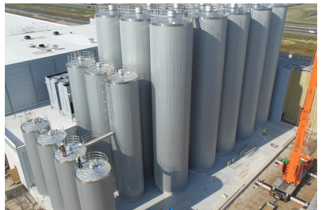
Abbildung 8: Alternativ wird verschweißter Edelstahl verwendet.
