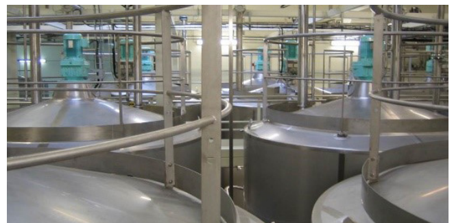
Abbildung 5: Alternativ können Rohmilchlagertanks im Innenbereich installiert werden.
